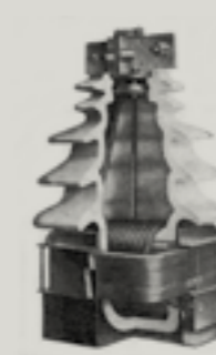
Abb. 13 Querloch-Stützerstromwandler, Koch & Sterzel, 1919
